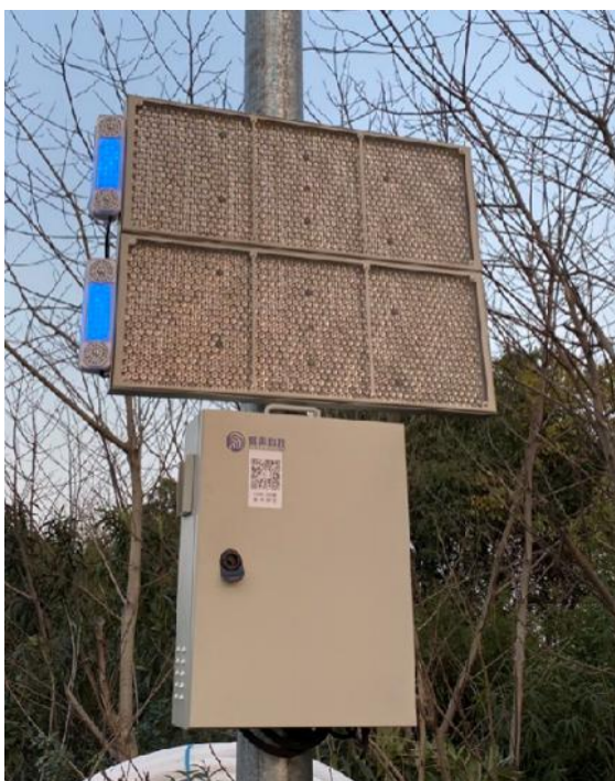
图12. 定向音柱安装示例
